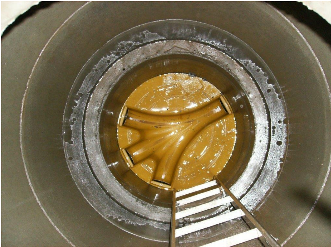
Figur 7: S6 ny spillvannskum klargjort for tilkobling av spillvann fra nytt skolebygg.
