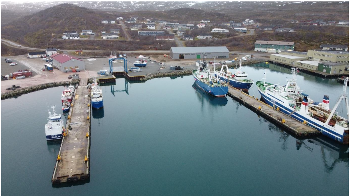
Bilde fra høsten 2022. Arbeid med byggevarehus er i gang. Kaianlegg er godt trafikkert.
